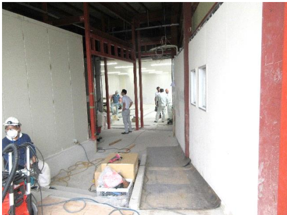
写真ではわかりにくいのですが、奥に見える新店舗には、緩い階段を下りて行くことになります。高低差があるため、壁側には緩いスロープを設けました。
