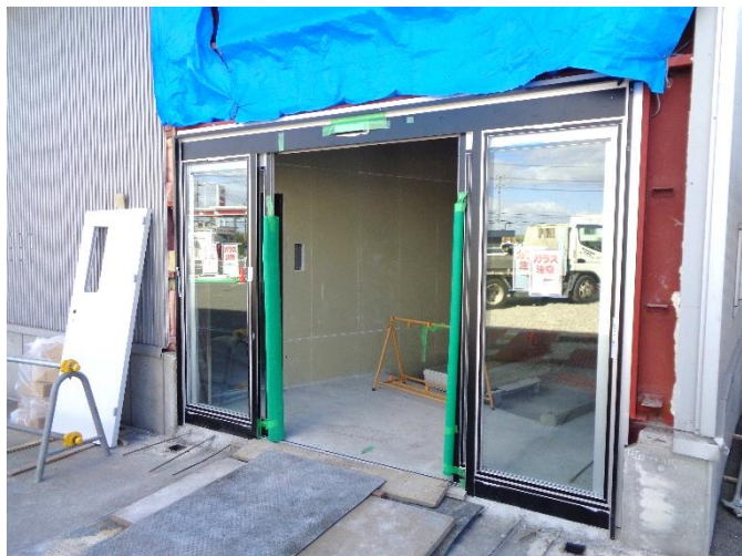
新店舗の入り口に自動ドアを設置しているところです。入ってすぐ左手に貸金庫、緩い階段を降りるとATMが見えてきます。
