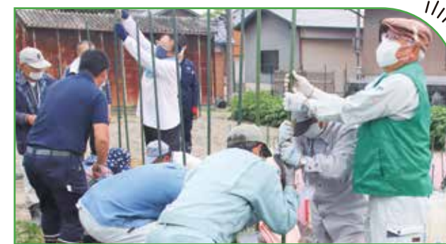
協力して支柱を設置
